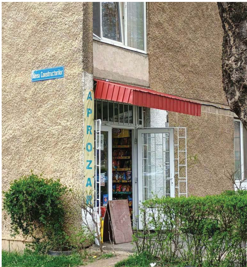
Fig. 13 - Vedere de ansamblu de la nivelul utilizatorilor din micro-cartierul Tractorul
