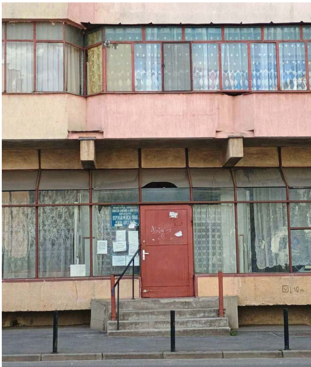
Fig. 17 - Vedere de ansamblu de la nivelul utilizatorilor din micro-cartierul Piața Tractorul
