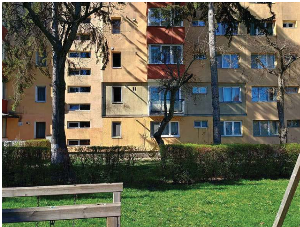
Fig. 28 - Vedere de ansamblu de la nivelul utilizatorilor din micro-cartierul Saturn
