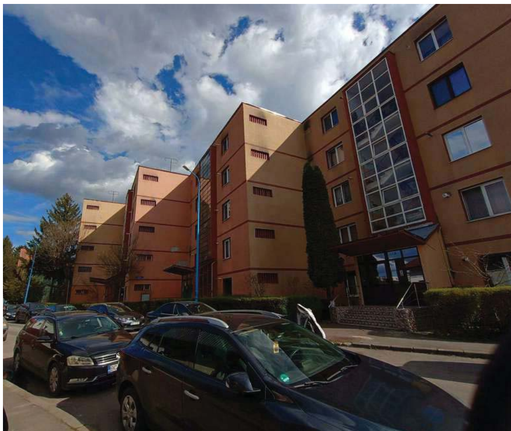
Fig. 34 - Vedere de ansamblu de la nivelul utilizatorilor din micro-cartierul Piața Tractorul
