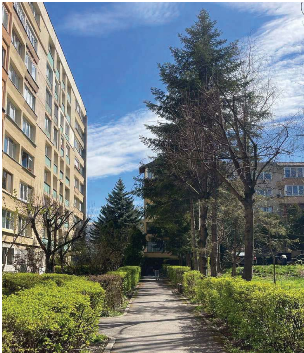
Fig. 24 - Vedere de ansamblu de la nivelul utilizatorilor din micro-cartierul Hărmanului
