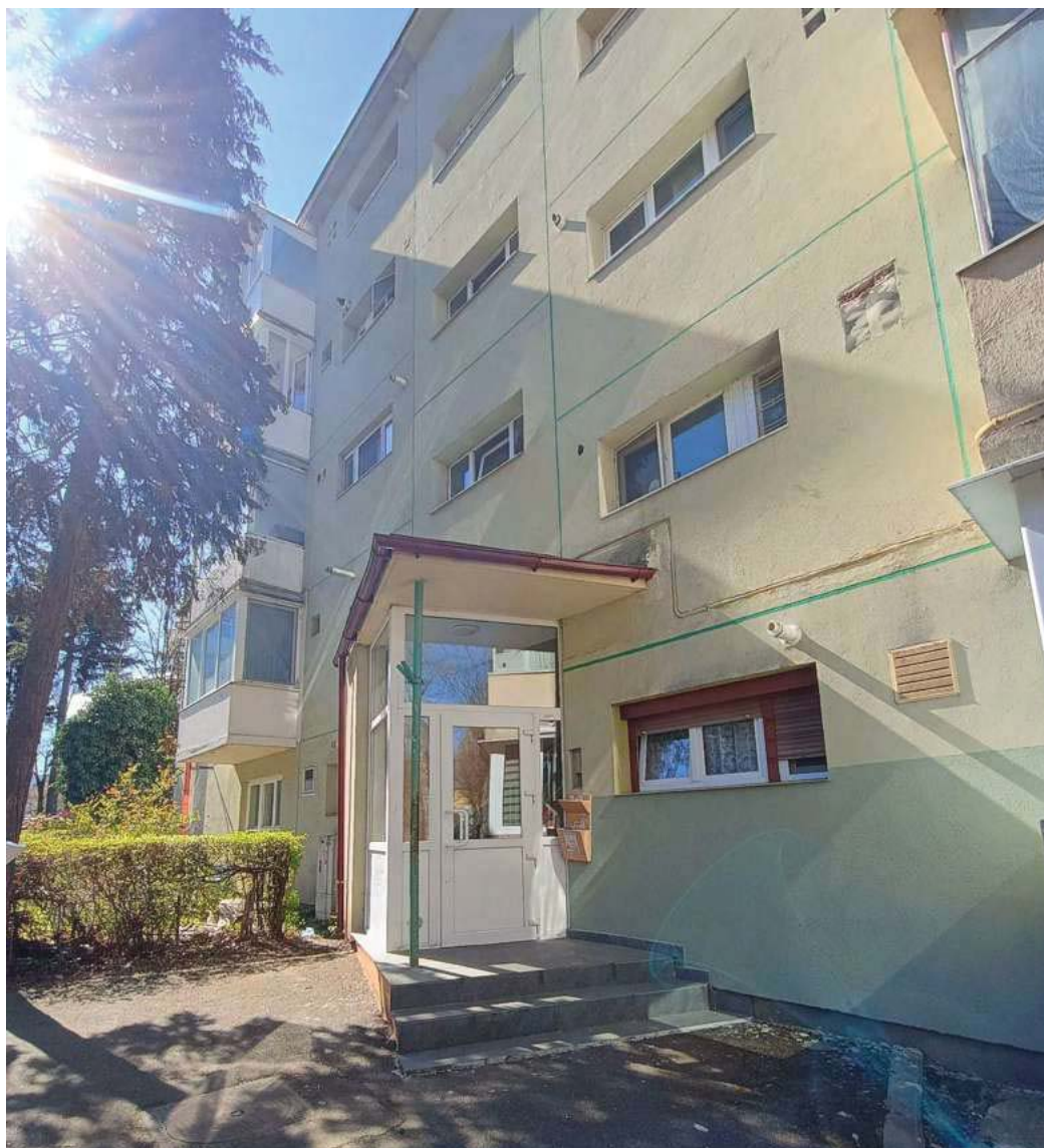
Fig. 27 - Vedere de ansamblu de la nivelul utilizatorilor din micro-cartierul Astra
