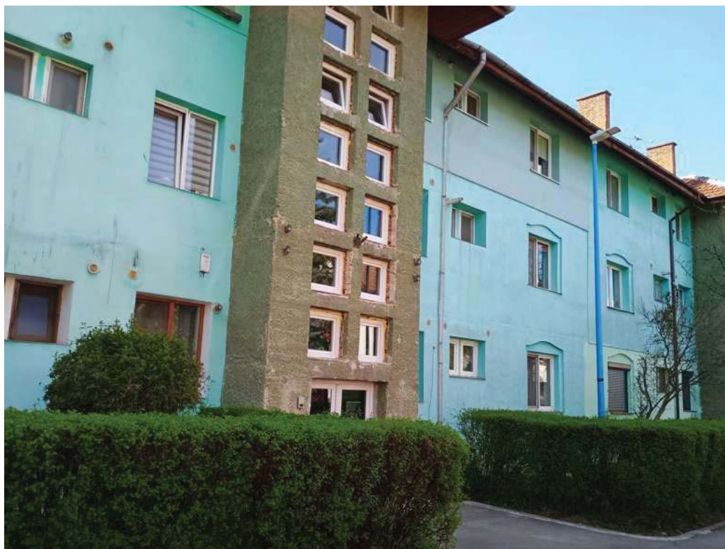
Fig. 16 - Vedere de ansamblu de la nivelul utilizatorilor din micro-cartierul Piața Tractorul
