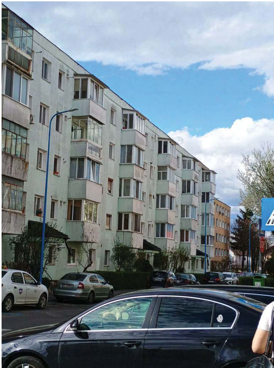
Fig. 15 - Vedere de ansamblu de la nivelul utilizatorilor din micro-cartierul Tractorul
