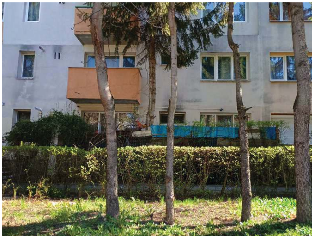
Fig. 29 - Vedere de ansamblu de la nivelul utilizatorilor din micro-cartierul Saturn
