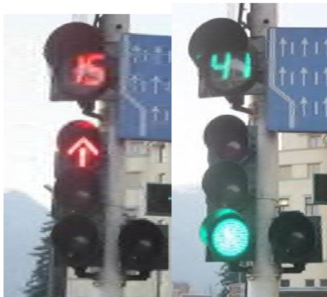
Figura 2.44 Temporizatoare tip „numărătoare inversă” la semafoarele pentru vehicule din intersecția Lunga – N. Iorga
